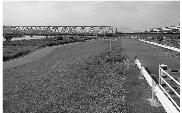
綾瀬川の法面を上がった所（左が荒川）
