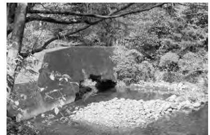
図1：底が抜けた古い砂防ダム（九州）
