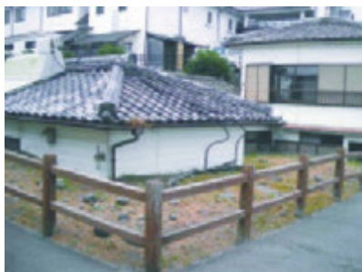
写真-26：土石流で埋没した住宅、道の駅に展示
