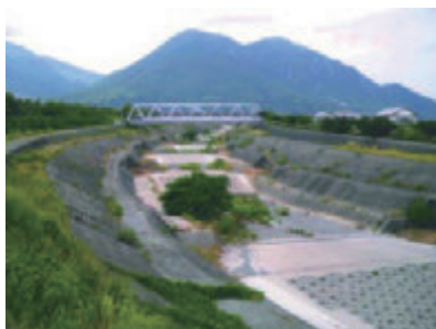
写真-27：嵩上げされた水無川の堤防
