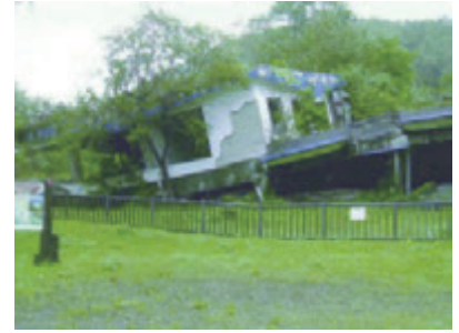
写真-31：火山遺構公園病院跡
