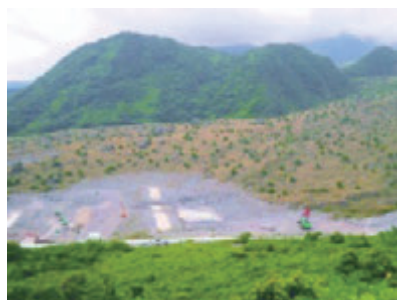
写真-24：今も続く土砂除去工事
