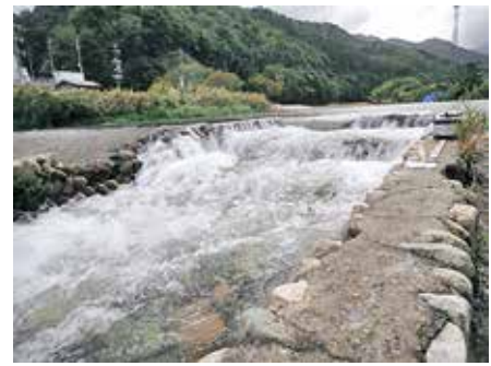
図8 用瀬発電所堰の魚道の写真
