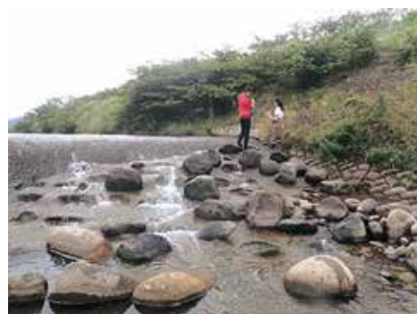
図14 永野堰の小わざ魚道の写真
