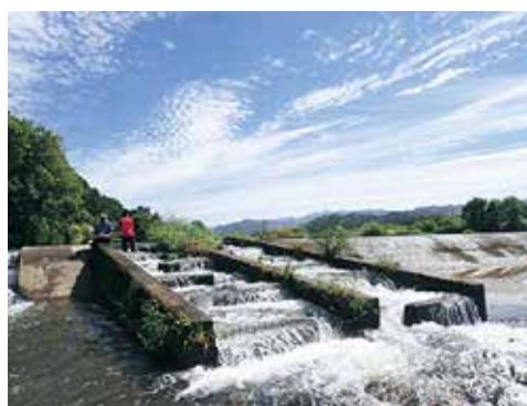
図17 永野堰の階段魚道の写真
