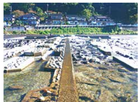
図2 大口堰の魚道の写真
