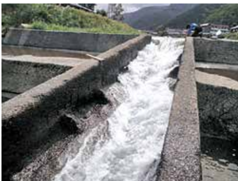
図11 鹿ノ子堰の魚道の写真
