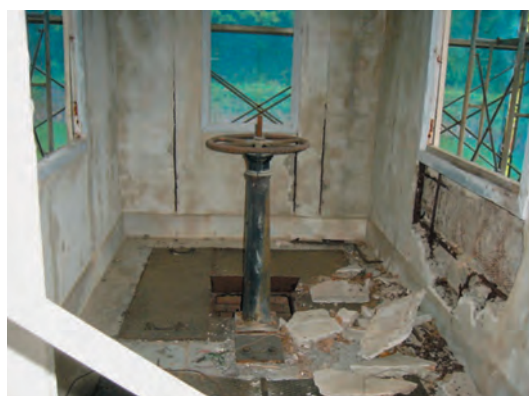
濾過池調整井上家・内部
