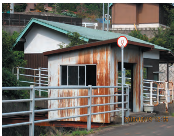
写真7. 乗客の有無が確認しづらく、夜間は暗い
