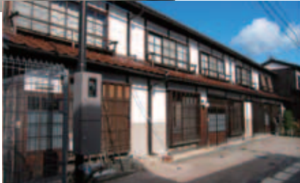
写真2-1 「倉吉市白壁土蔵群①」 外観を守りながらの暮らし
