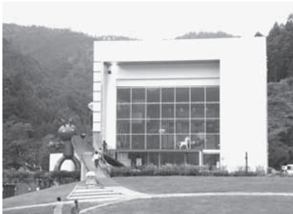
建物にも世界観が活かされている。
