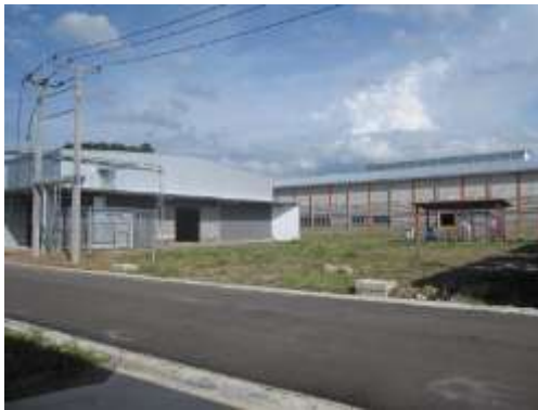
写真 4-9 建設中の SP2 プロジェクト・サイト
