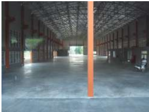
写真 4-11 建屋内の設備の設置状況
