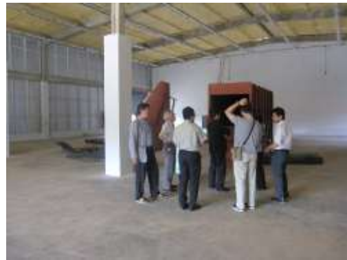
写真 4-10 建屋内の設備の設置状況
