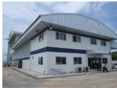
写真 4-2 精米工場の全景
