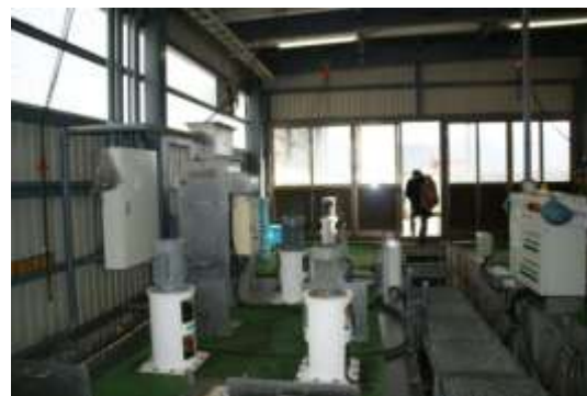
写真 5-37 堆肥化工場 内部
