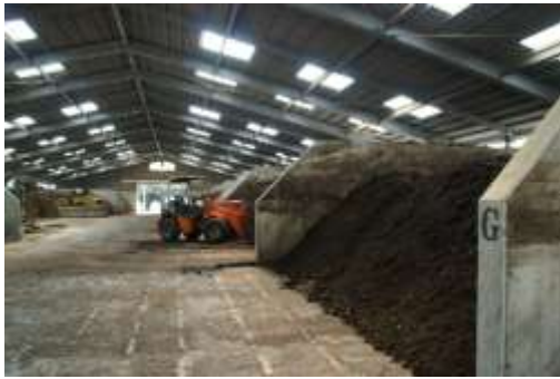
写真 3-15 堆肥センター内部
