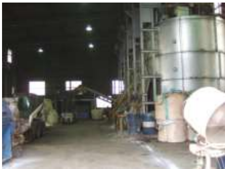
写真 5-4 コンポスト施設内部
