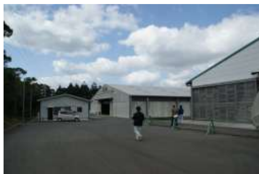
写真 3-14 南種子町堆肥センター
