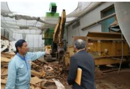
写真 3-9 積置ヤードでの機械破砕
