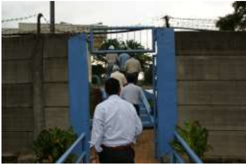
写真 4-51 処分場 浸出水処理施設
