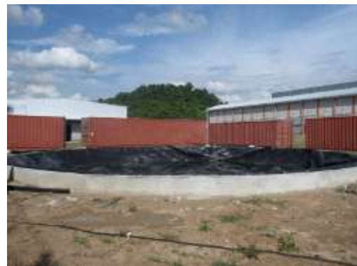
写真 4-12 屋外設備の設置状況
